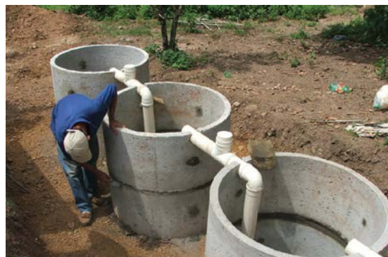
Bau der Kleinkläranlage. Aus Tecnologia social. Fossa séptica biodigestora.
