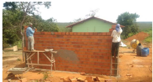
Bau des neuen Schlafsaals an der EFAV.
